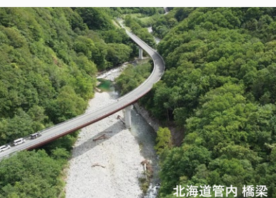
北海道管内 橋梁
