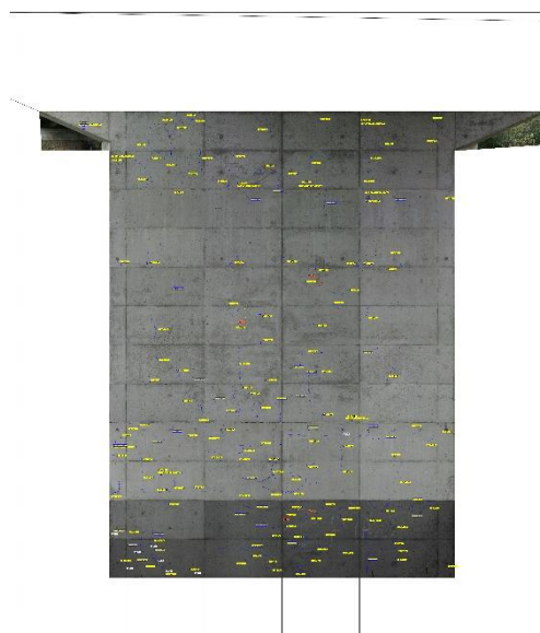
04 合成画像／損傷表示
