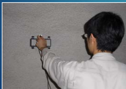
塗装仕上 浮き確認
