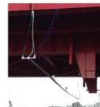
橋梁下面の近接目視 支援用簡易装置 「診れるんです」
