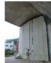
橋梁等構造物の 点検ロボットカメラ
